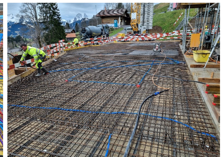
Decke über Untergeschoss Etappe 2
