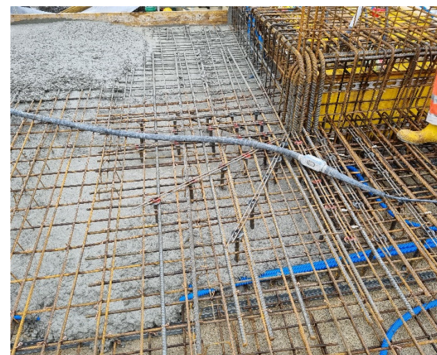
Decke über Untergeschoss Etappe 1
