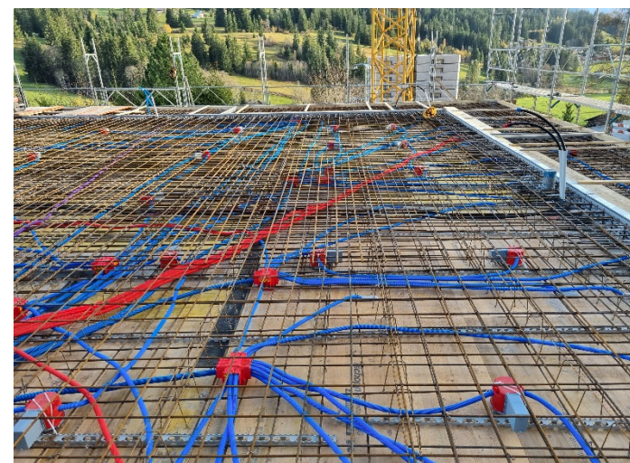
Decke über Erdgeschoss
