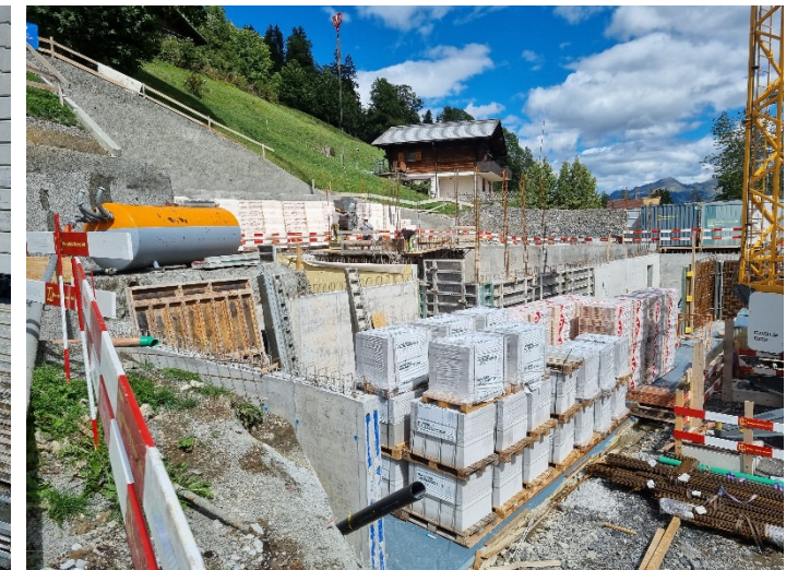
Wände im Untergeschoss
