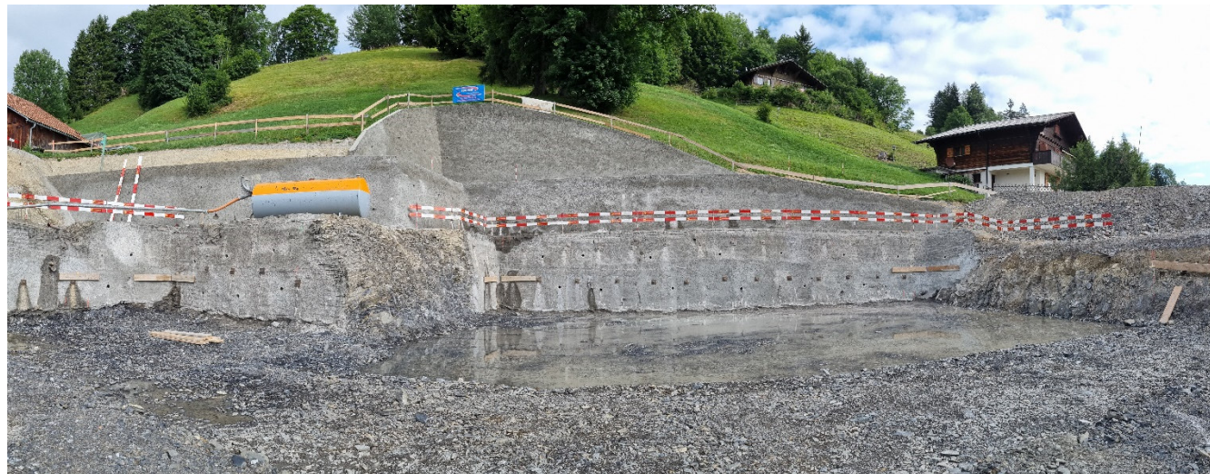
Baugrubenaushub mit Nagelwänden
