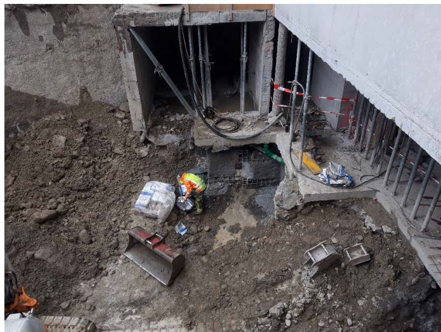
Aushub für Anbau Hallenbad
