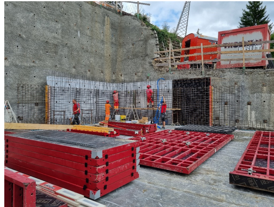
Wände im 5.UG / Nagelwand
