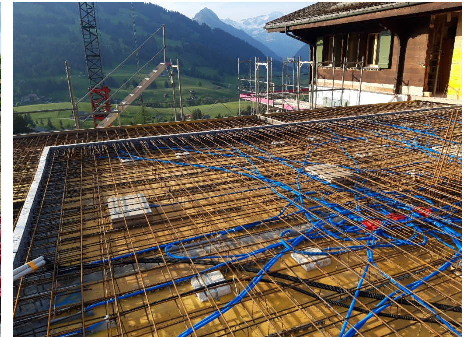
Decke über Erdgeschoss - Nebengebäude
