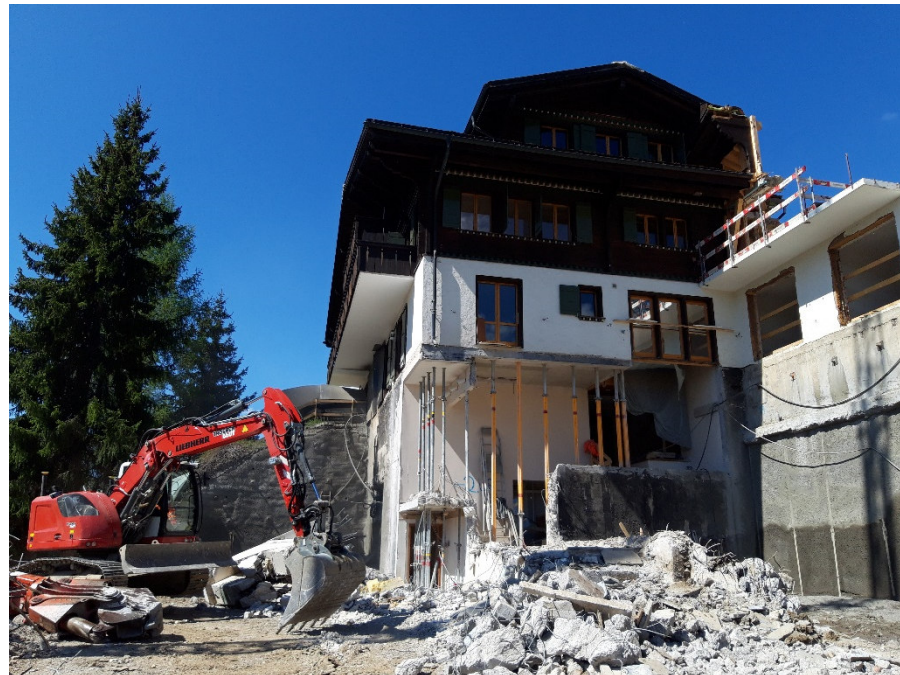
Aushub und Nagelwand / Abstützung Bestand
