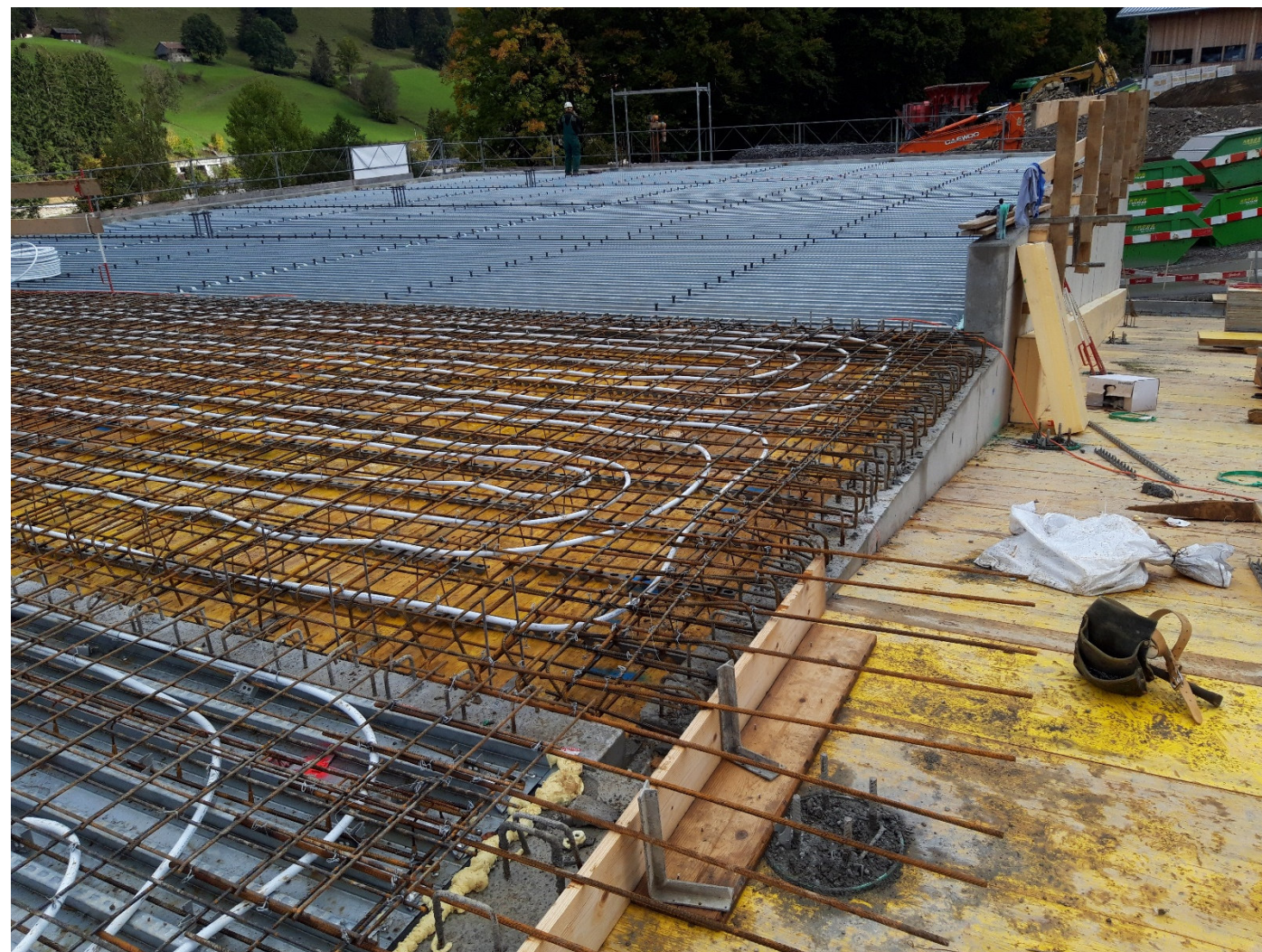
Decke über Erdgeschoss
