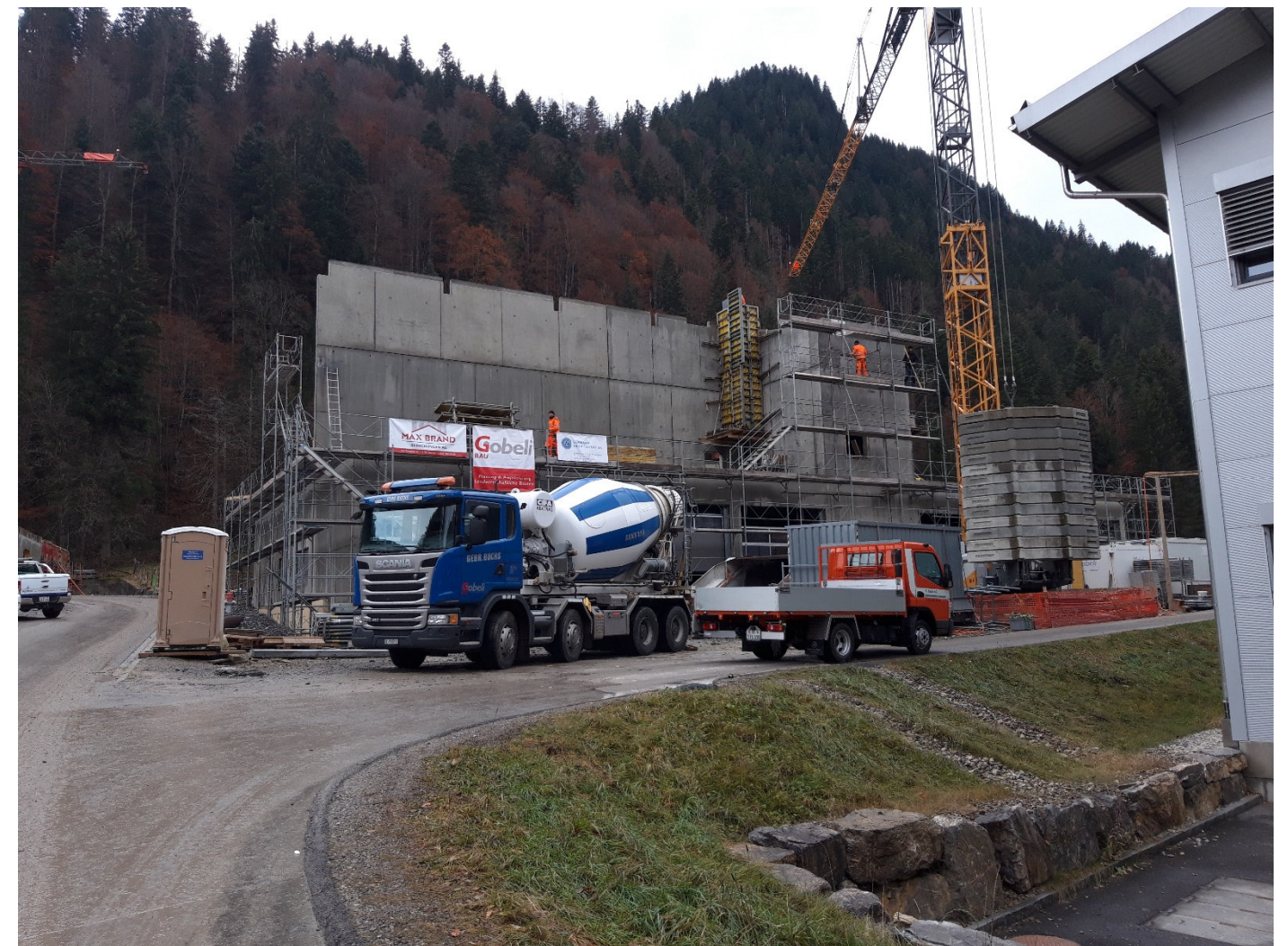
Wände im Erdgeschoss und Obergeschoss
