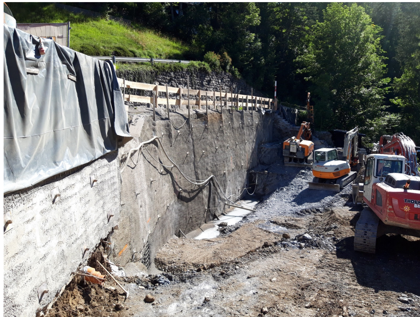
Aushub und Nagelwand
