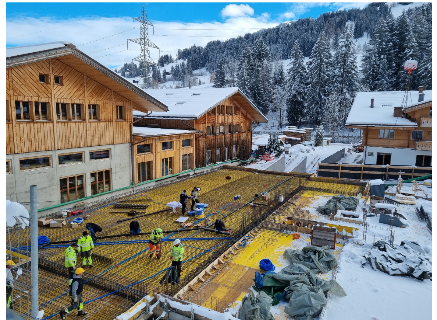
Decke über Einstellhalle
