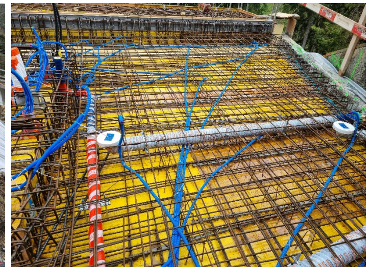
Decke über Erdgeschoss
