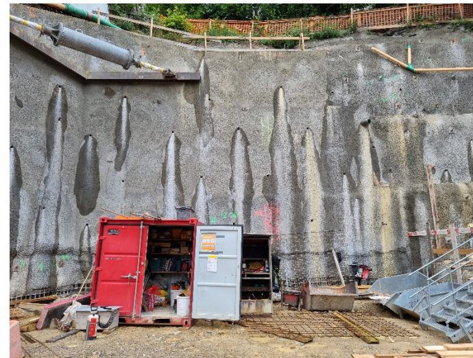
Baugrubenaushub mit Nagelwänden
