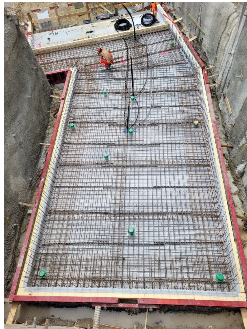
Bodenplatte 1. Untergeschoss Etappe 1
