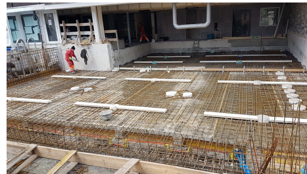
Armierung Decke über Technik
