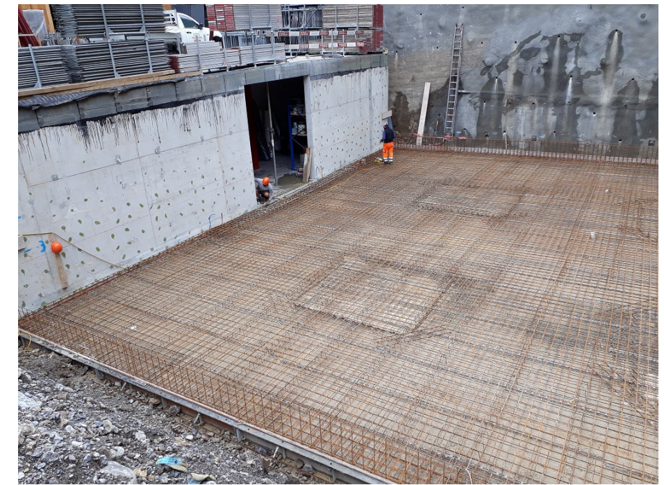
Armierung Bodenplatte Etappe 2
