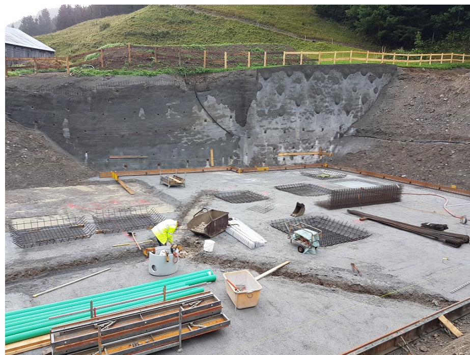
Vorbereitung Bodenplatte Etappe 1
