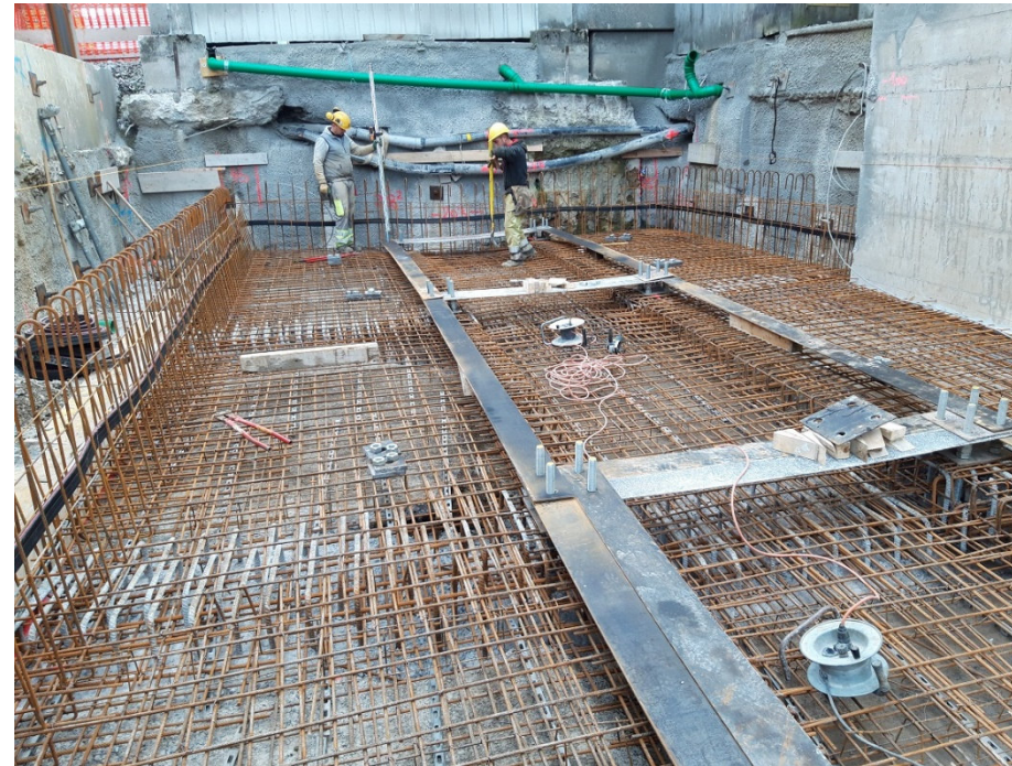
Armierung Bodenplatte Erweiterung
