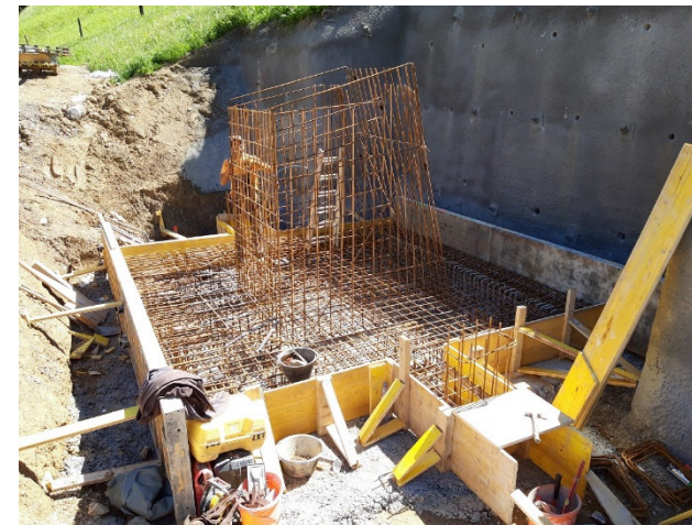
Armierung Fundament Stütze3
