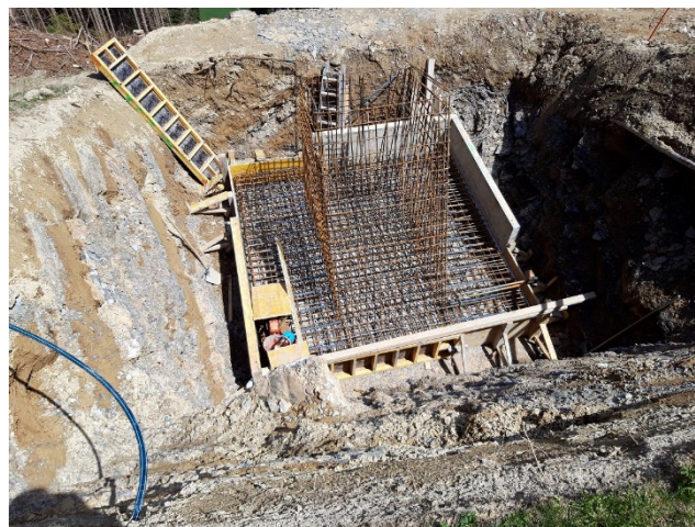
Armierung Fundament Stütze 7
