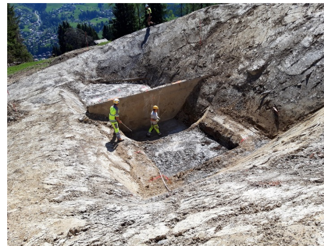
Aushub Fundament Stützen 10 und 11
