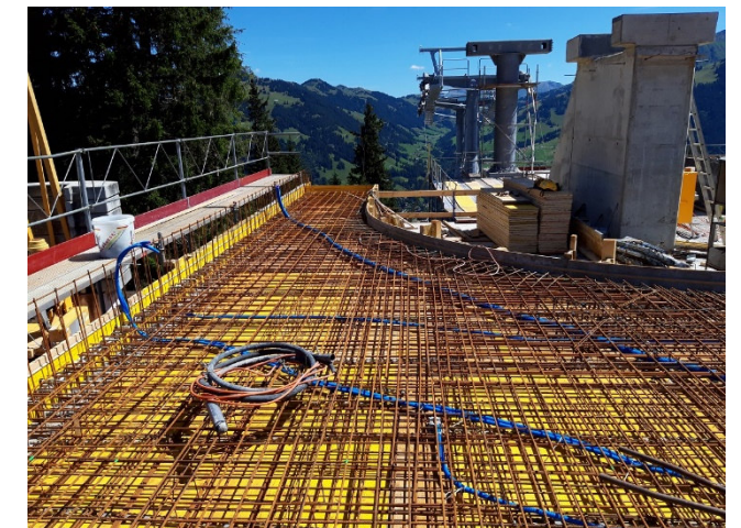
Armierung Decke Untergeschoss Bergstation
