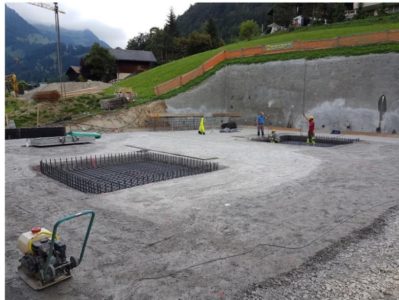
Fundamentvertiefungen / Nagelwand
