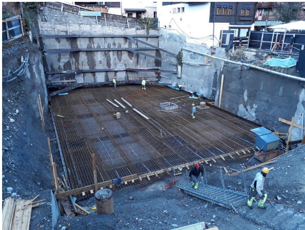
Armierung Bodenplatte Häuser A+B
